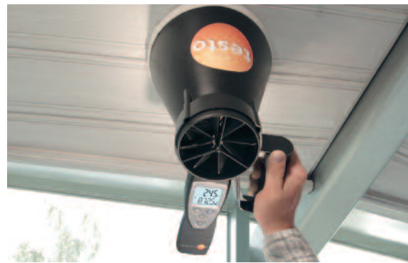
Kontrolle der Zuluft an einem Tellerventil
